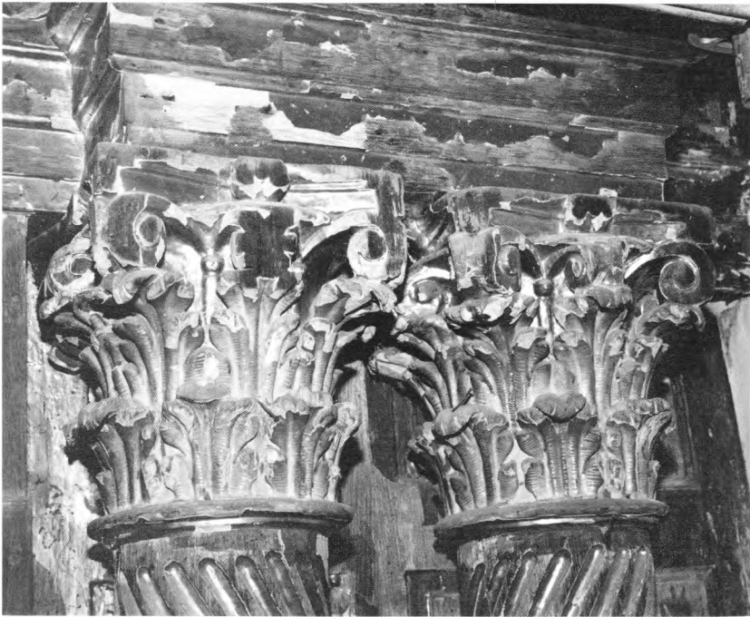
Capiteles antes de la restauración, la policromía estaba muy perdida y con zonas repintadas de color amarillo para ocultar faltas.
