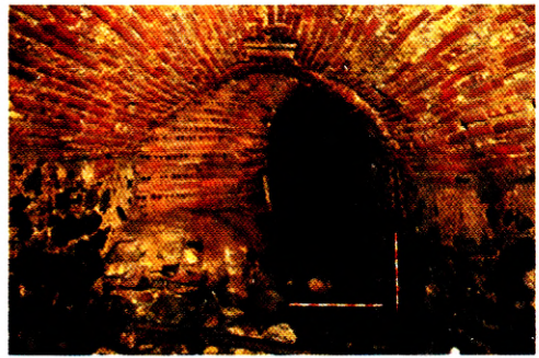
5.4 Tramo bajo la casa nº 43 de la calle Galdámes
