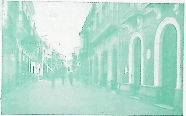
Calle CRISTÓBAL COLÓN
